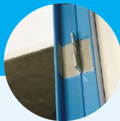
Assemblage par clavetage
