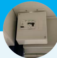
Les équipements électriques, guichet, ventilation, sont installés directement en usine
