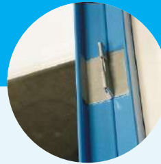
Assemblage par clavetage
