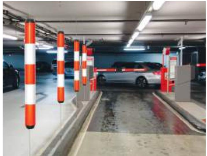
Balise suspendue réfléchissants en polyéthylène avec câble d'acier pour fixation au plafond et fixation au sol.
