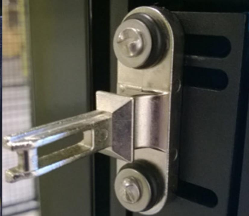
OK : l'actionneur ne peut pas être retiré grâce à la fixation par vis à sens unique
