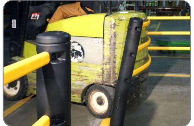
Les rambarde rigides sont défectueuses suite à une seule collision et ont besoin d'être réparées ou changées
